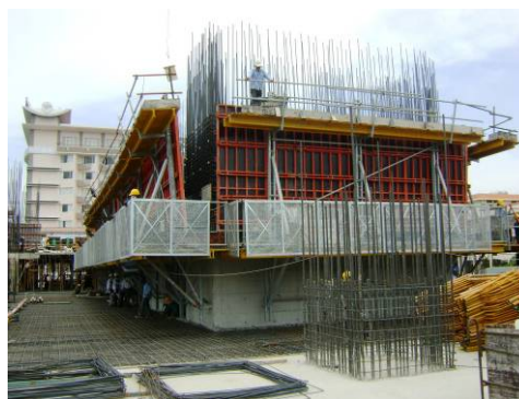
Hệ thống Coffa lan can an toàn
