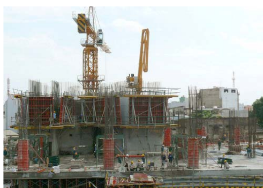
Cầu tháp, cần bơm bê tông
